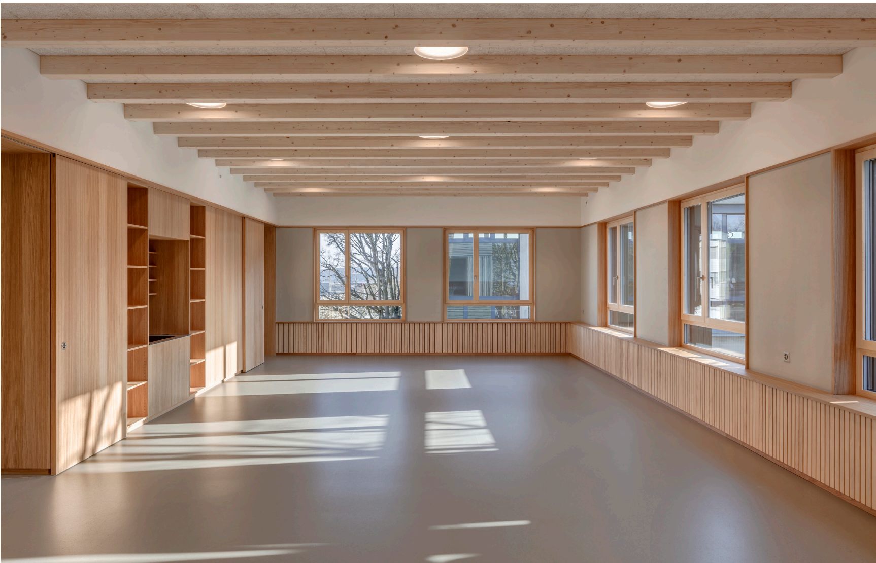
Hauptraum mit Holzbalkendecke, Schrankwand mit Schiebetüren als Raumteiler sowie Brüstungsverkleidung mit integrierter Haustechnikinstallationen
