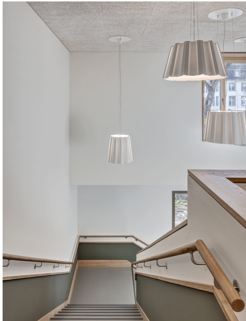
Treppenhaus mit Wandschutz und absenkbaren Pendelleuchten
