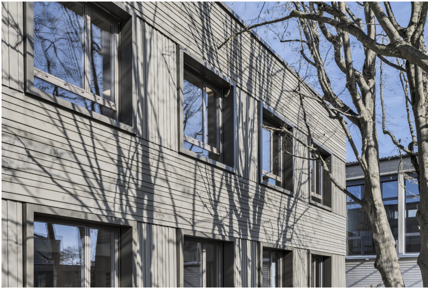
Gliederung der Aussenfassade mit horizontaler und vertikaler Stulpschalung
