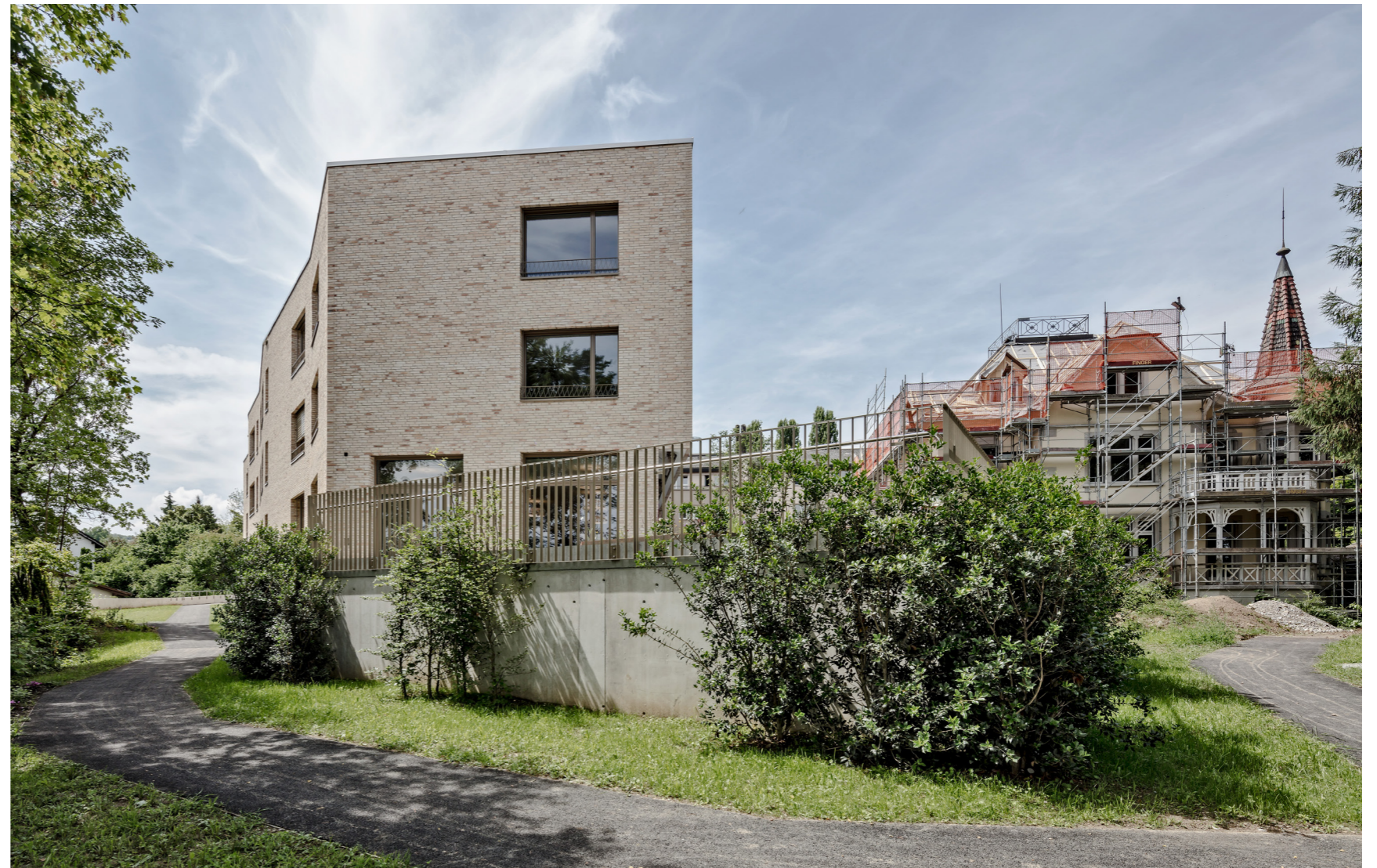
Neubau Nordfassade mit Klinkermauerwerk und Dementengarten
