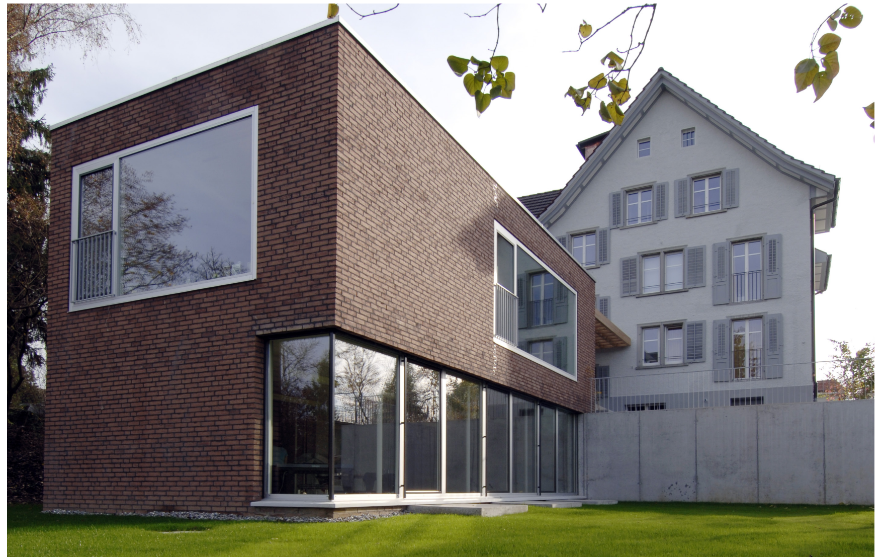
Altbau und Erweiterung
